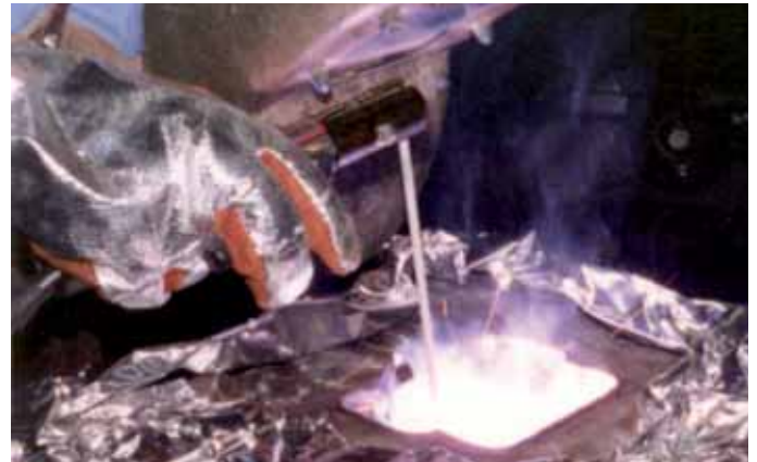
Lichtbogenhandschweißen mit dem Abdecken der Bauteile
